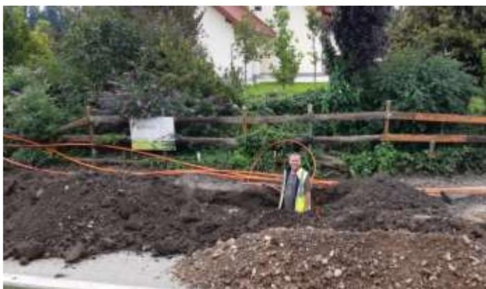
Der Glasfaserausbau schreitet zügig voran. Polier Reiter Hans von der Fa. Spindler bei der Leerrohrverlegung.
